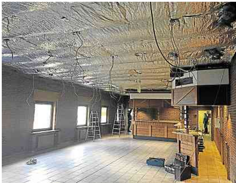
Momentan ist das Haus Hergispach in Herschbach/Uww. eine Baustelle.
